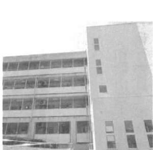
右側が後から増設されたエレベーター
